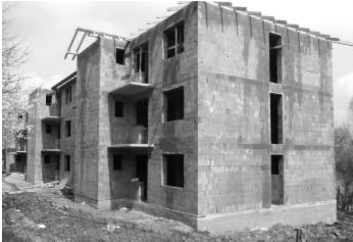
18-bytovka na Záhradnej
