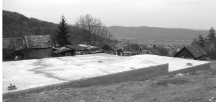
Základy bytovky na Prieložnej
